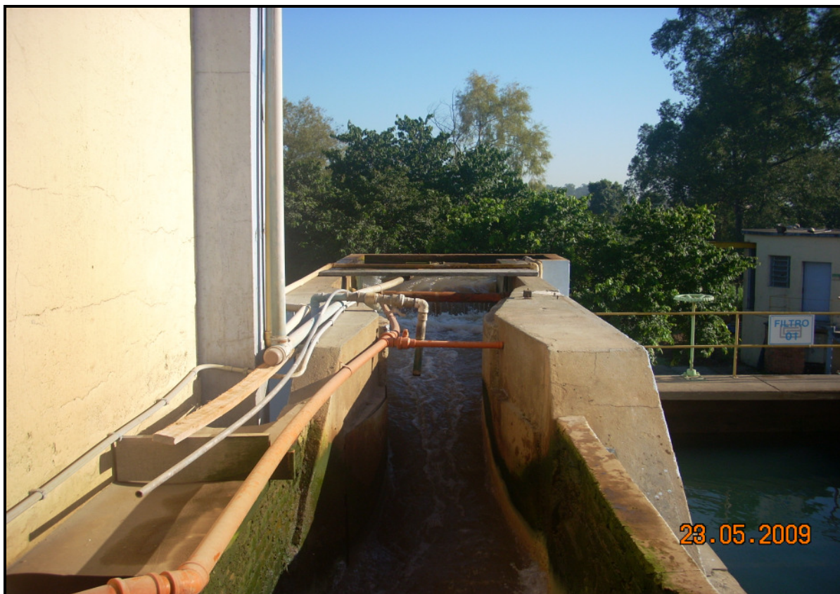
Figura 6 – Calha Parshall na ETA da CORSAN, Esteio, RS, 2009. Fonte – Elaborado pelo autor.
