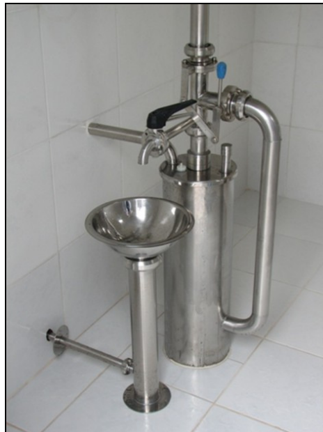
Figura 8 – Dispositivo cabeça de poço
