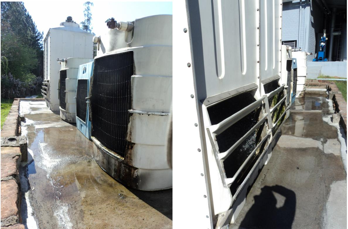
**Figura 17 - Torres de resfriamento utilizadas no sistema de refrigeração 1.**
