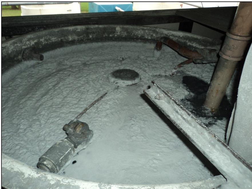
**Figura 16 - Reservatório do *chiller* sistema 1.**
