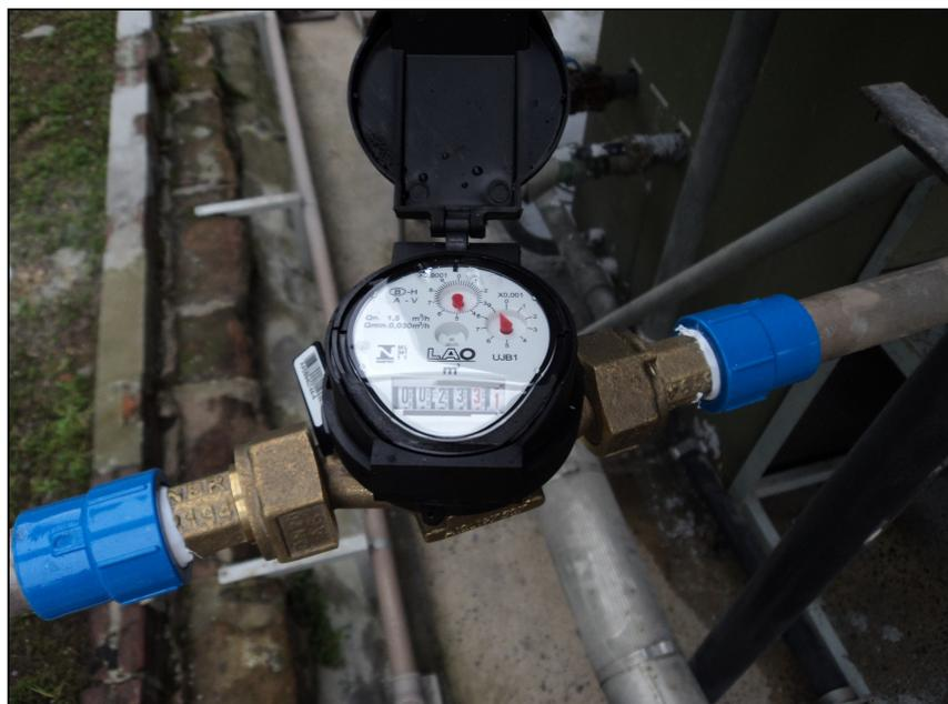
**Figura 10 - Hidrômetro da marca LAO.**
