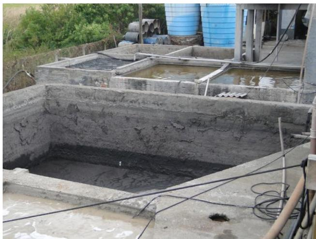
**Figura 9 - Tanque de recebimento do efluente líquido (bruto)**
