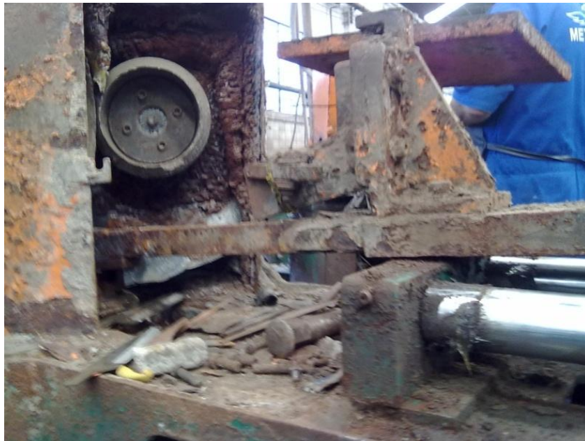
Figura 25 – Braço do equipamento a ser reformado. Fonte: Imagem Chanfradeira Metalcan, 2012.
