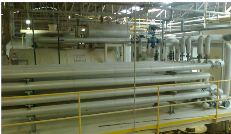
**Figura 3. Trocador de calor tipo duplo tubo**
