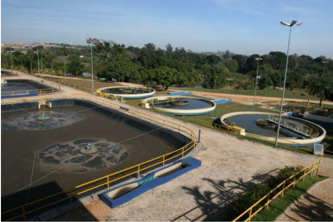
Figura 3 – Estação de tratamento convencional, demonstrando as grandes dimensões dos tanques, e da grande área necessária.
