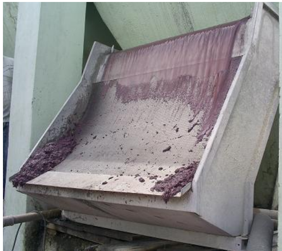
Figura 10 – Peneira Estática Hidrodinâmica, modelo PEH-1500, marca BBL.
