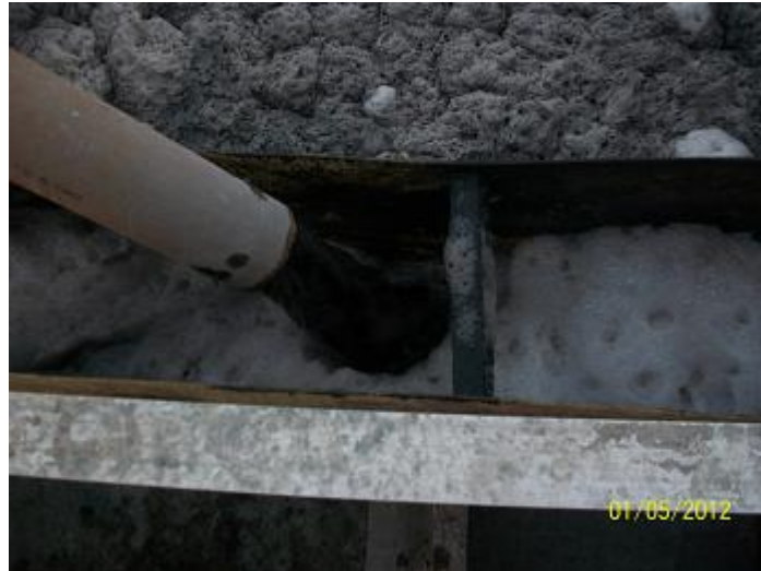
Figura 12 – Entrada do efluente bruto no reator eletroquímico, a uma vazão de 6\text{m}^3/\text{h} .
