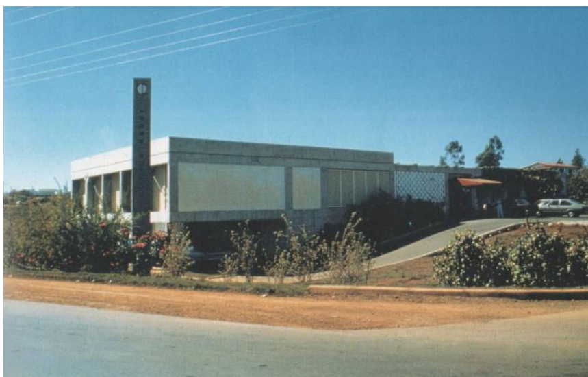
Imagem 93: Fachada da Clínica Daher (LATORRACA, 1999).
