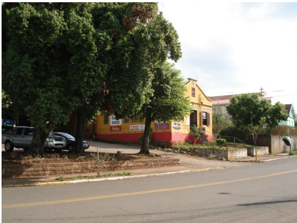
Imagem 61: Visual do terreno a partir da Rua Tuiuti, localizando uma das edificações que será retirada.
