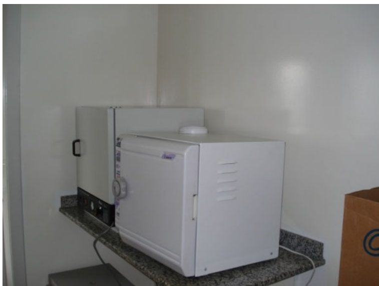
Imagem 29: Sala de esterilização
