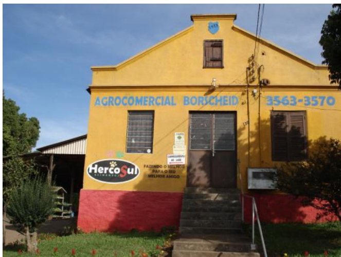
Imagem 51: Edificação 1 situada no lote, que será retirada.
