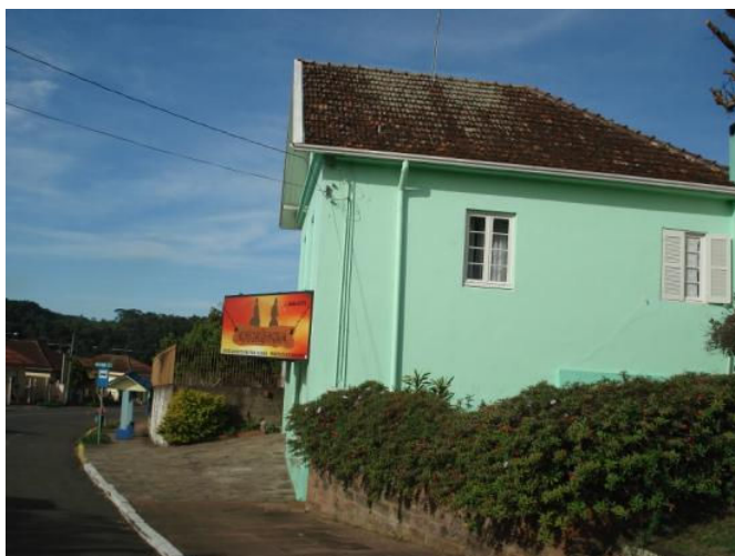
Imagem 52: Edificação 2 situada no lote, que será retirada.
