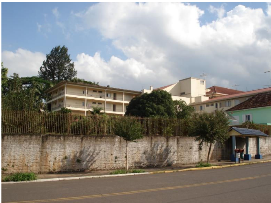
Imagem 63: Visual do terreno a partir da Rua Tuiuti, identificando a edificação que será retirada e ao fundo o Hospital São José.
