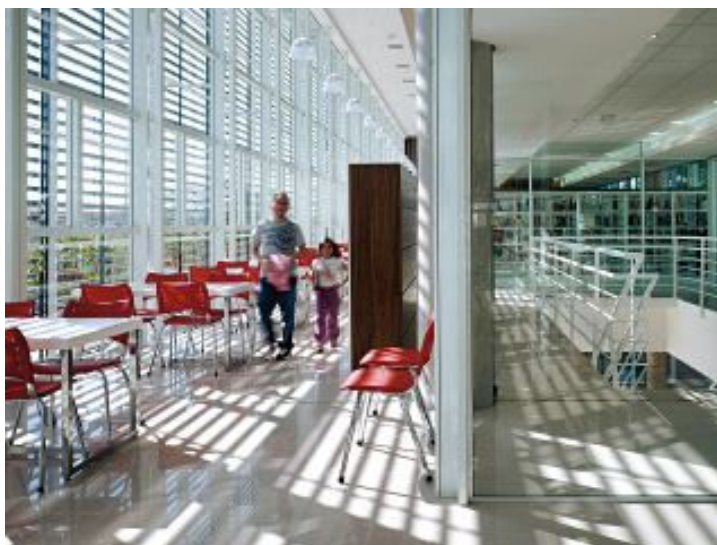
Imagem 82: Interior do ambiente protegido por brises horizontais (ARCOWEB, 2009a)
