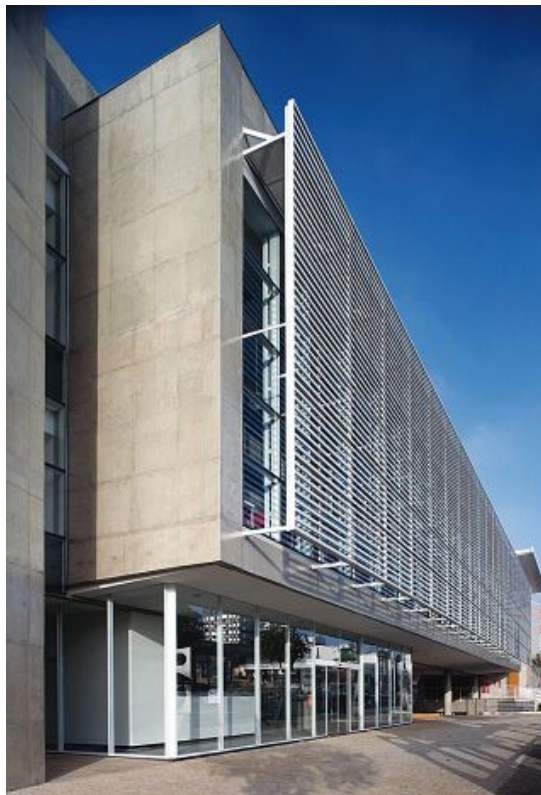
Imagem 81: Brise metálico horizontal (ARCOWEB, 2009a).
