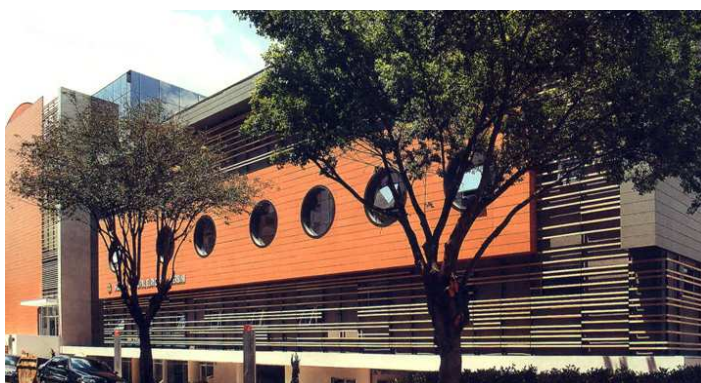
Figura 27 - Fachada da nova edificação
