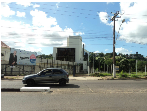
Imagem 9 – Foto mostrando a edificação vizinha em relação à divisa do lote.
