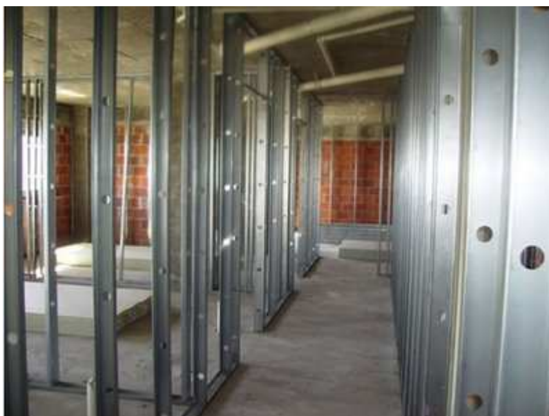
Imagem 22 – Montantes do painel wall.
