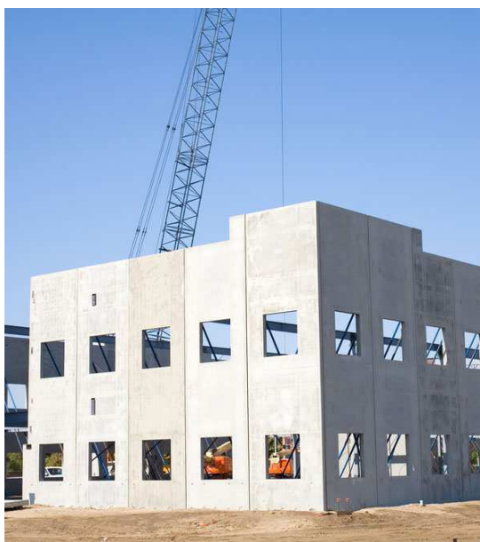
Figura 34 – Montagem da estrutura Tilt-up com içamento das paredes.
