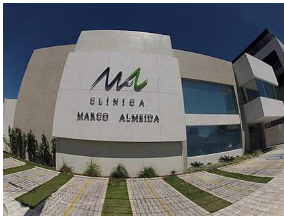
Figura 13 - Vista externa da Clínica
