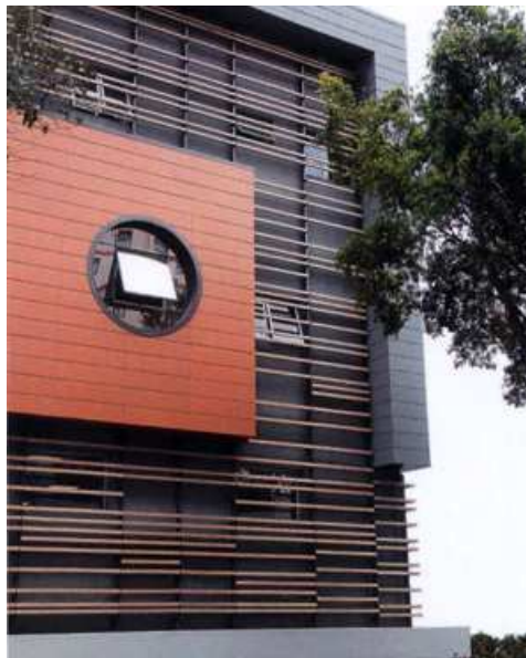
Figura 29 - Fachada com brise cerâmico
