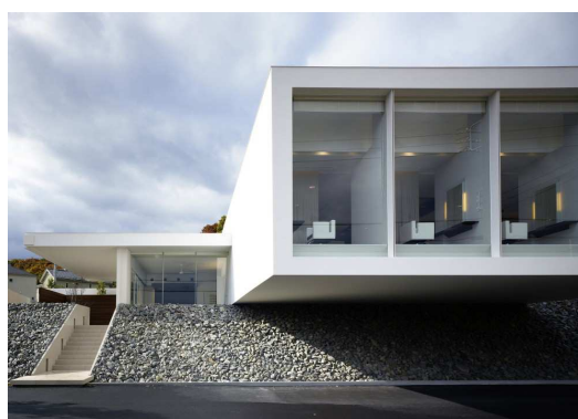
Figura 24 - Vista frontal da edificação
