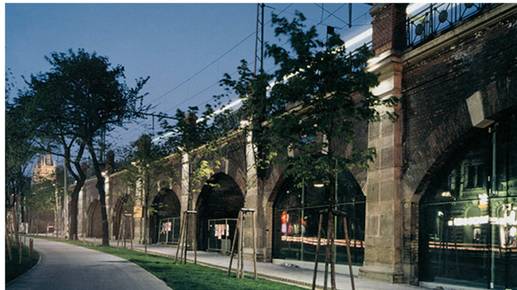
Figura 15: Viaduto de Viena.
