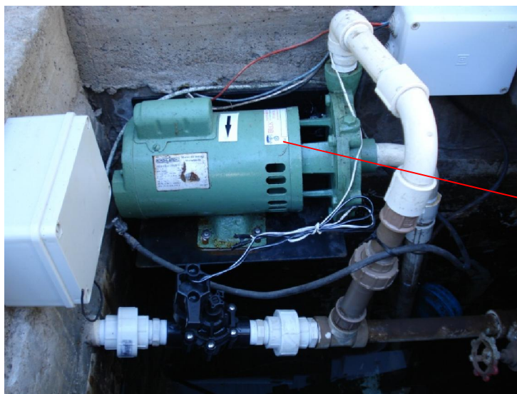
Figura 5.2 – Detalhe da bomba d'água instalada Fonte: O Autor (2012)
