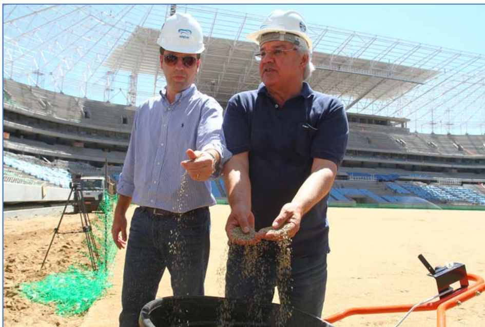
Figura 24 – Odone à direita durante a construção da Arena
