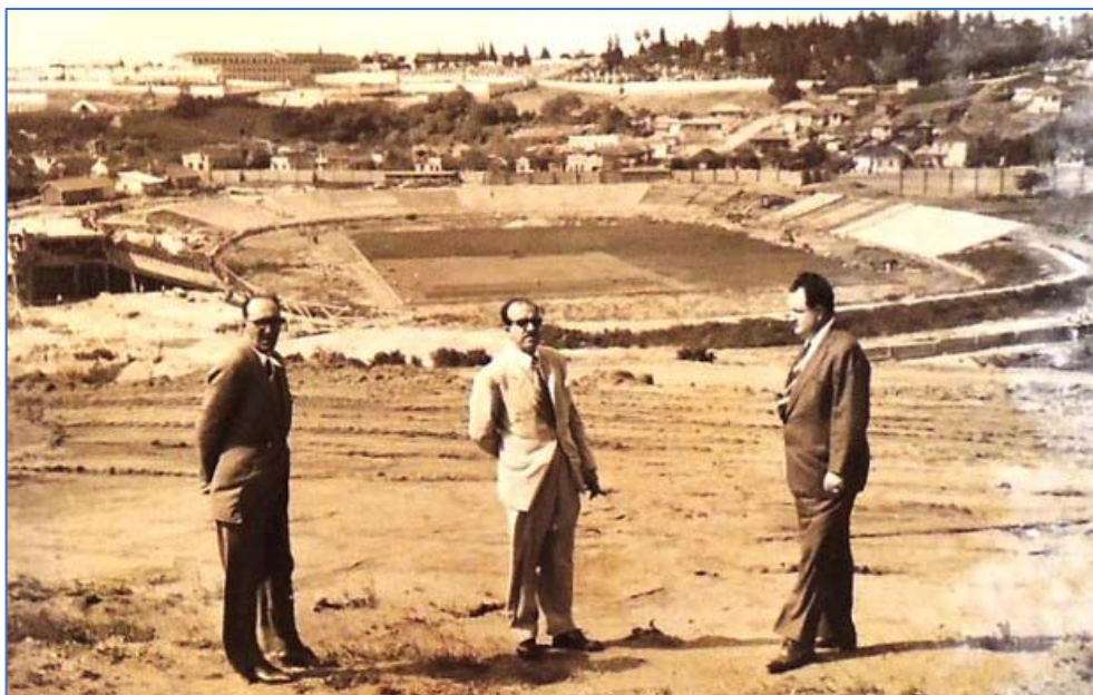
Figura 23 - Vanzelotti ao centro, durante a construção do Olímpico
