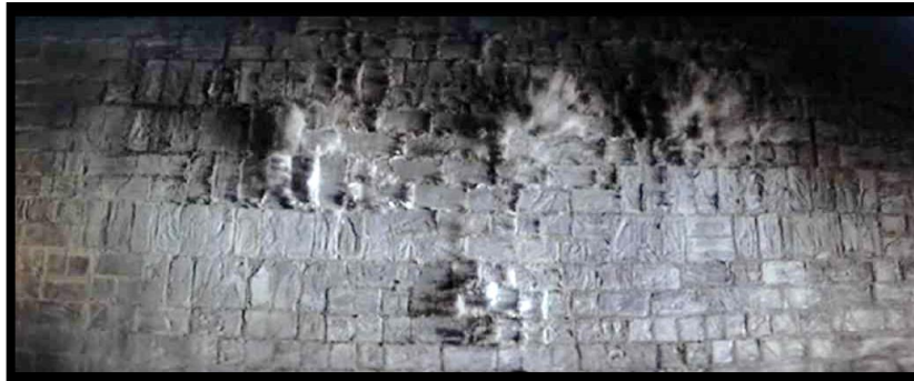
Figura 30 – Muro finalmente se destrói.
