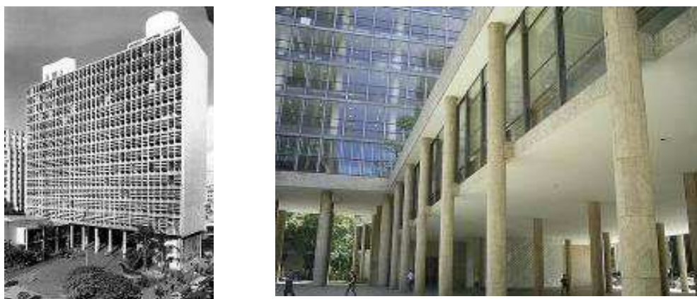
Figura 16 – Prédio do Ministério da Saúde e Educação. Primeiro prédio característico do Modernismo brasileiro - 1936. Fonte: < http://www.niemeyer.com.br > Acesso em: 01 mai 2010.
