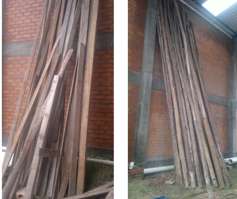
Figura 2 e 3 - Tábuas e escoras de madeira que sobraram da construção.
