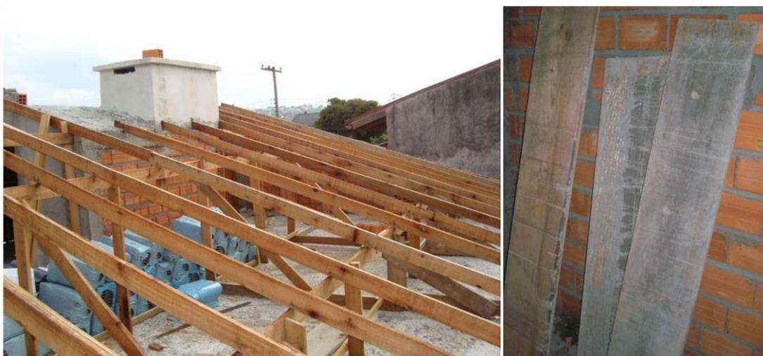
**Figura 19 - Madeira de eucalipto**
