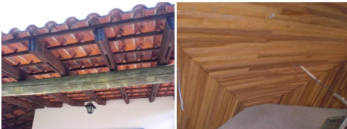
**Figura 21 - Aplicação da madeira em telhado e forro**
