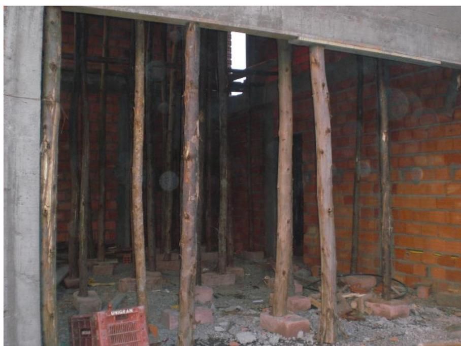
**Figura 18 - Escoras de eucalipto, elemento utilizado em obras residenciais**
