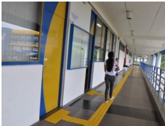
Figura 2 - Sinalização com piso tátil.
