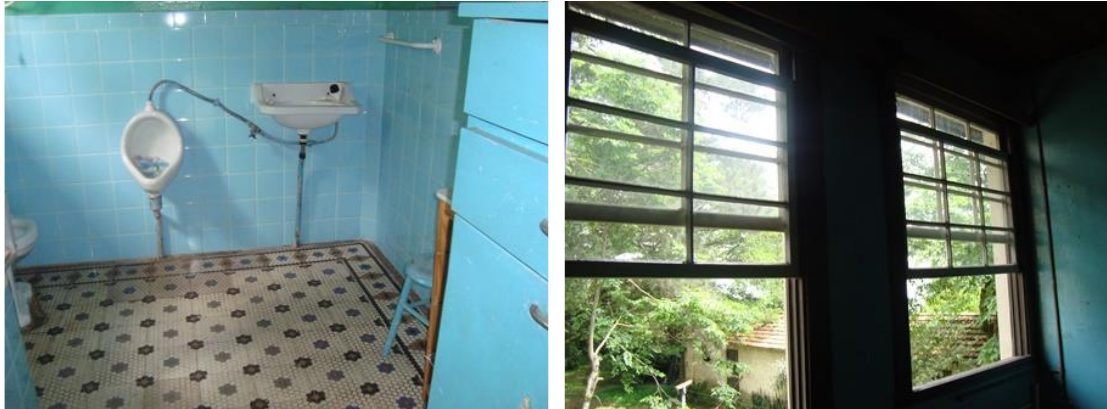
Figura 70 – Sanitário e janelas da varanda, respectivamente
