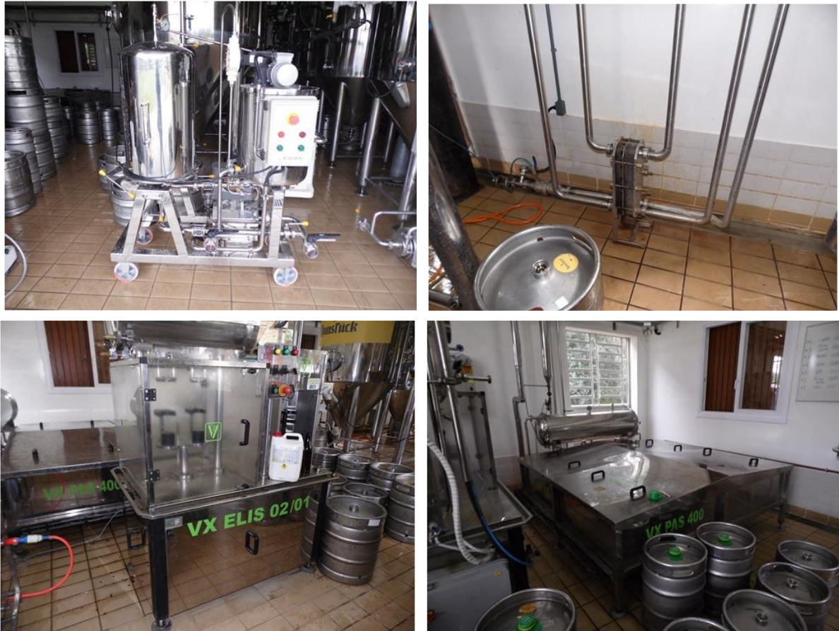
Figura 21 – Filtro, trocador de calor, envasadora e pasteurizador, respectivamente
