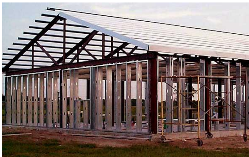
Figura 75 – Estrutura metálica com fechamento em steel framing
