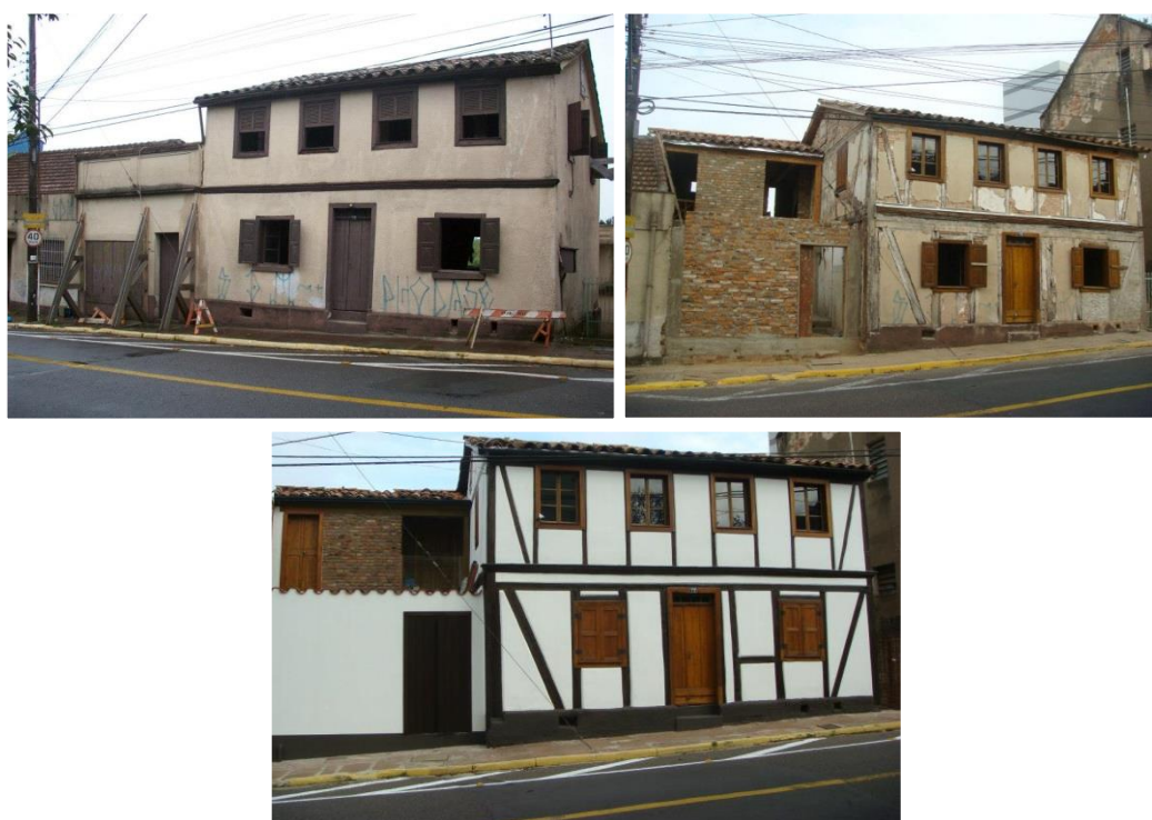
Figura 28 – Casa Kayser, antes, durante e depois da reforma
