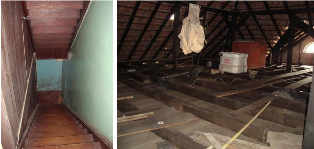
Figura 71 – Escada e sótão, respectivamente
