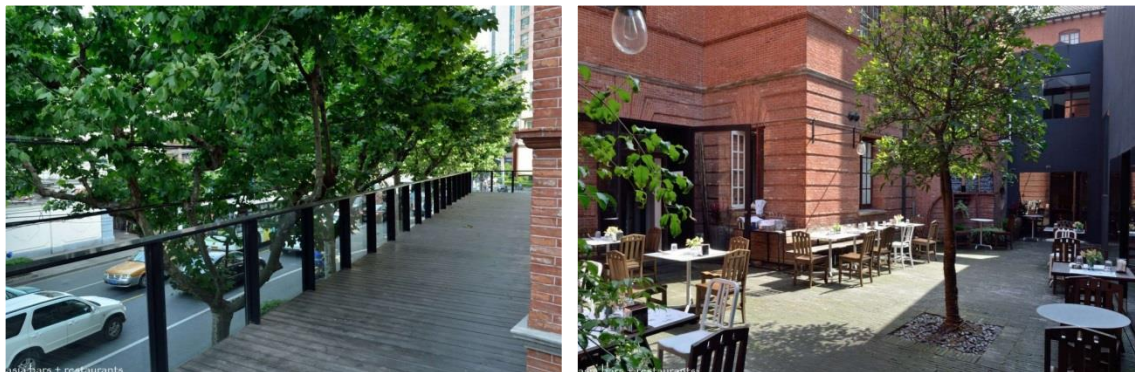
Figura 44 – Área externa do terraço e do pátio interno
