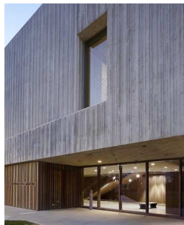
Figura 81 – Museu Clyfford Still em concreto aparente
