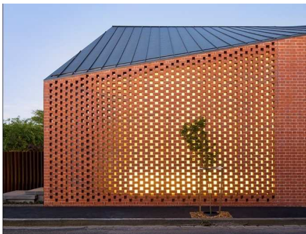
Figura 80 – Residência em Harold Street com fechamento vazado de tijolos
