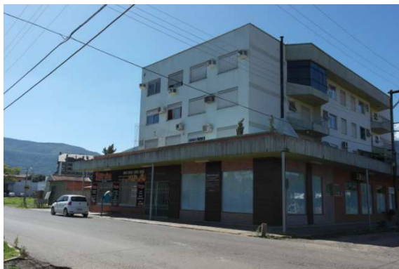
Figura 47 – Edificação do entorno
