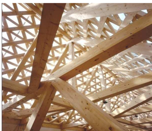
Figura 78 – Monastério em Trauta com estrutura de madeira
