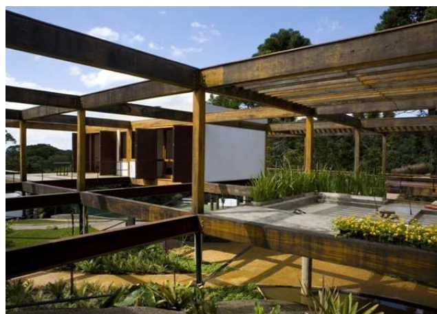
Figura 83 – Casa Grelha com estrutura de aço
