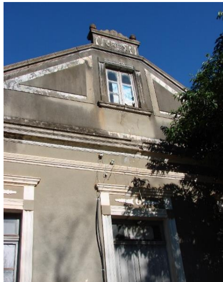
Figura 23 – Casa Deuner – Casa de frontão recortado inventariada em Campo Bom (RS).
