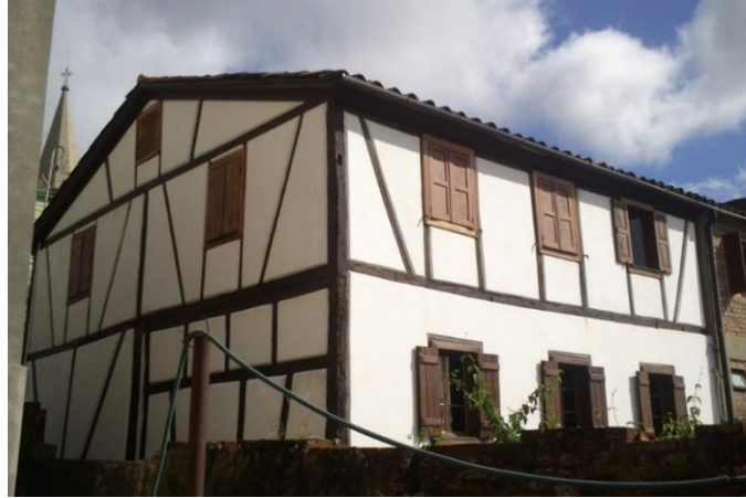
Figura 13 – Casa Kaiser, recentemente descaracterizada, integra sítio em processo de tombamento pelo IPHAN em Hamburgo Velho, Novo Hamburgo (RS).
