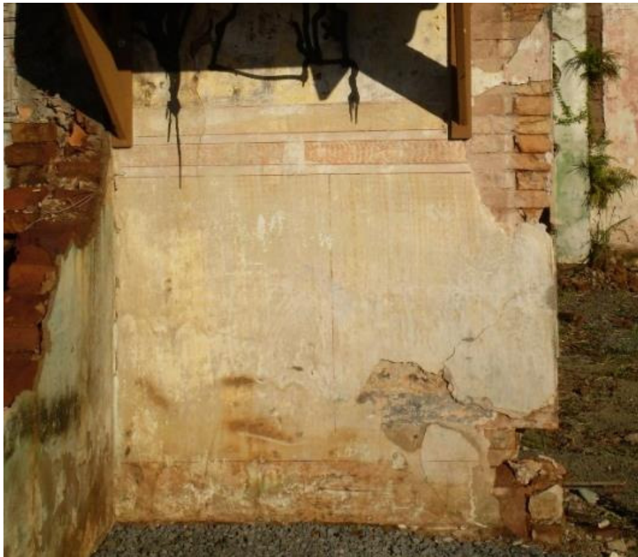
Figura 58 – Aspecto atual interno das fachadas remanescentes – escaiolas.
