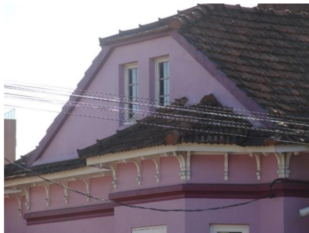
Figura 18 – Casa eclética no centro de Estância Velha (RS).
