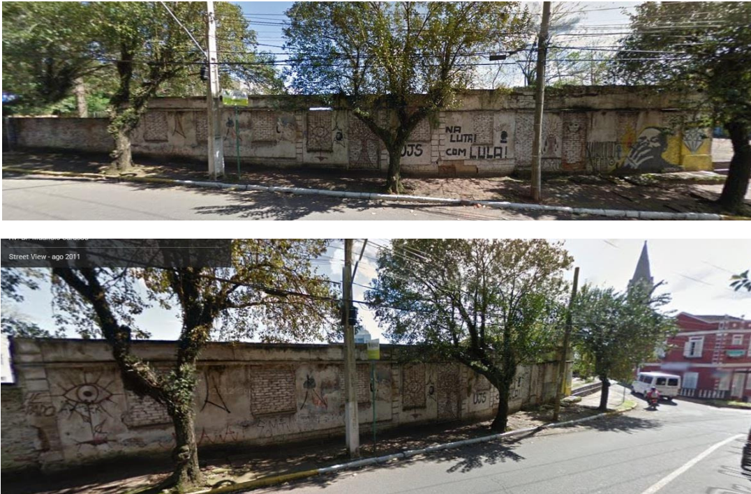
Figura 59 – Aspecto atual das fachadas remanescentes.
