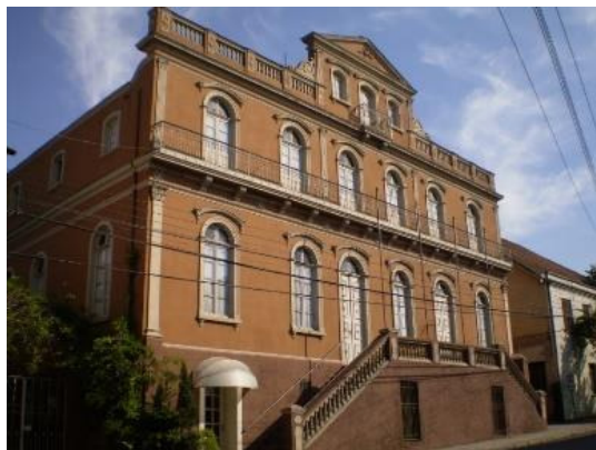
Figura 39 – Fundação Scheffel, na rua General Daltro Filho.
