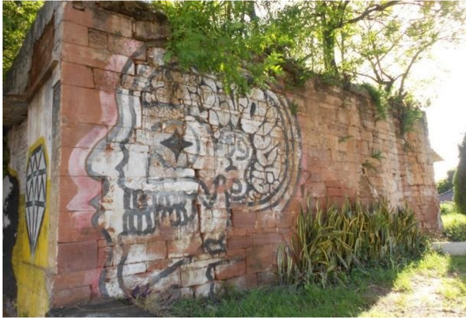
Figura 57 – Fachada norte - Casa Kroeff.
