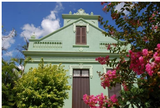
Figura 17 – Casa Soine – exemplar de frontão recortado tombado pelo município de Dois Irmãos (RS).
