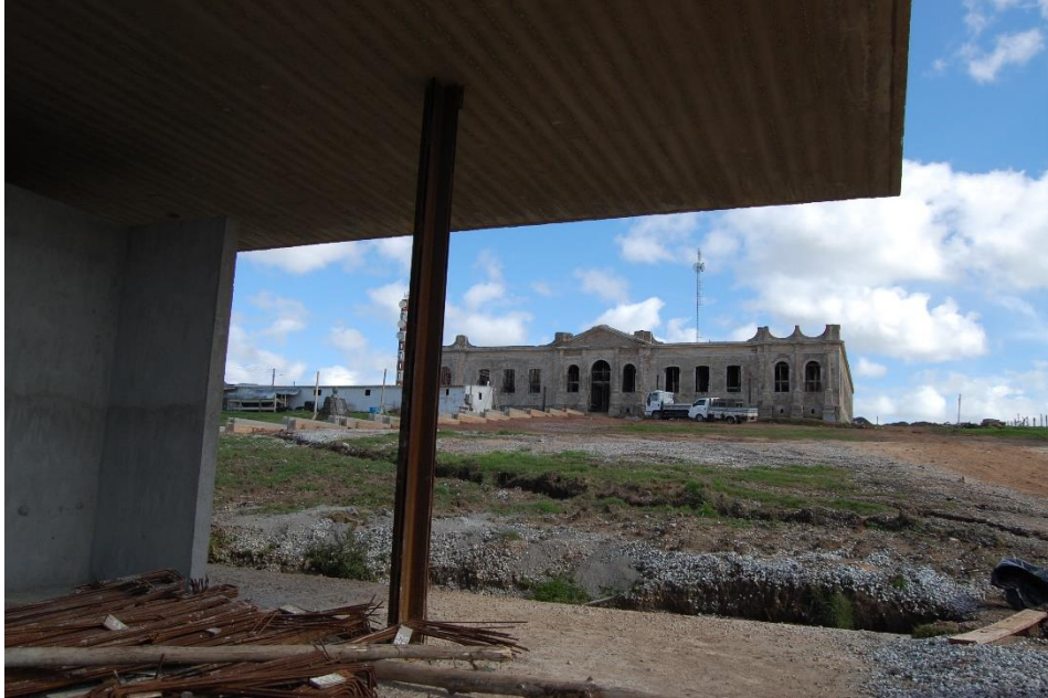
Figura 68 – Aspecto do novo bloco em relação a ruína.
