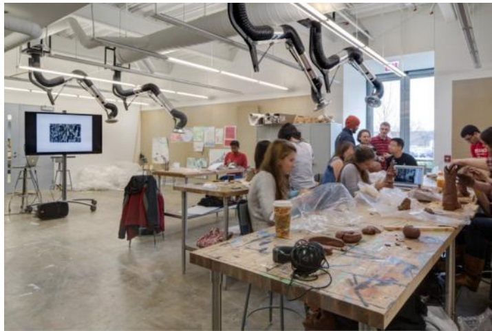
Figura 3 – Ateliê de Artes Visuais com exaustores
