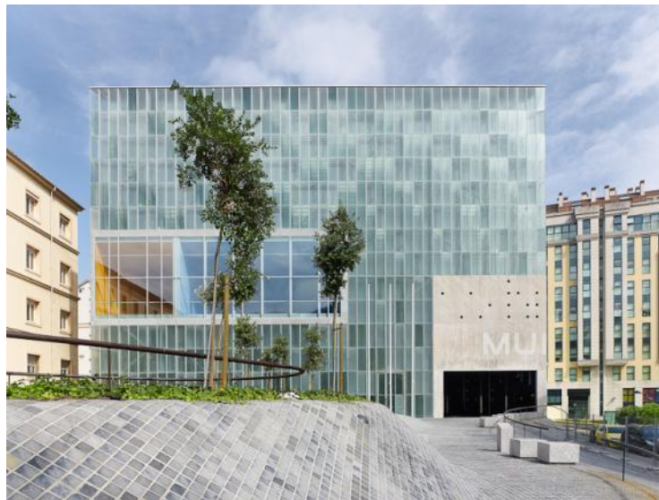
Figura 74 – Fachada de acesso do Conservatório e Museu de Dança
