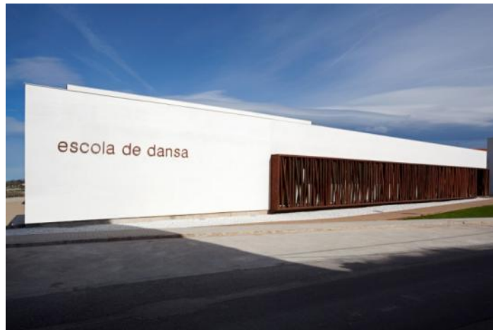
Figura 71 – Fachada principal da Escola de Dança
