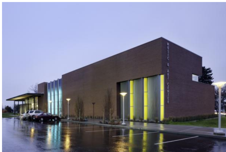
Figura 50 – Fachada de acesso da edificação
