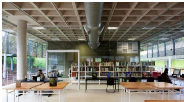
Figura 92 – Exemplo de aplicação de laje nervurada.
