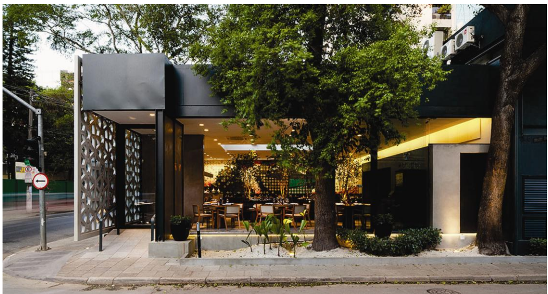
Figura 48 - Fachada da Rua Jusseapê
