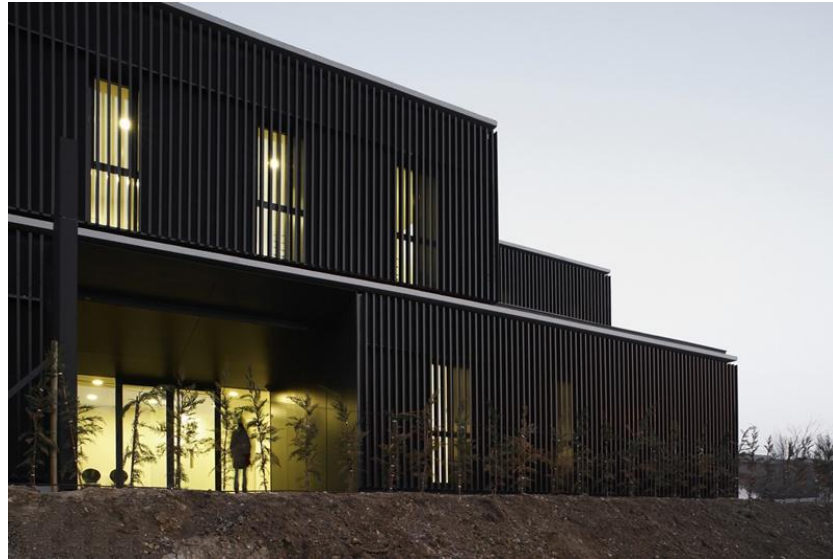
Figura 20 – Vista da fachada do prédio
