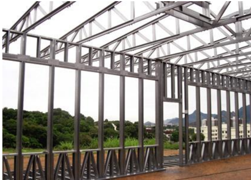
Figura 40 – Estrutura em Steel Frame
