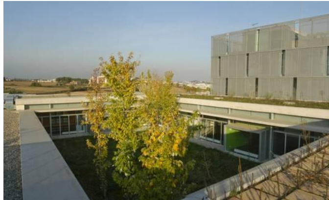
Figura 35 – Vista para o pátio interno
