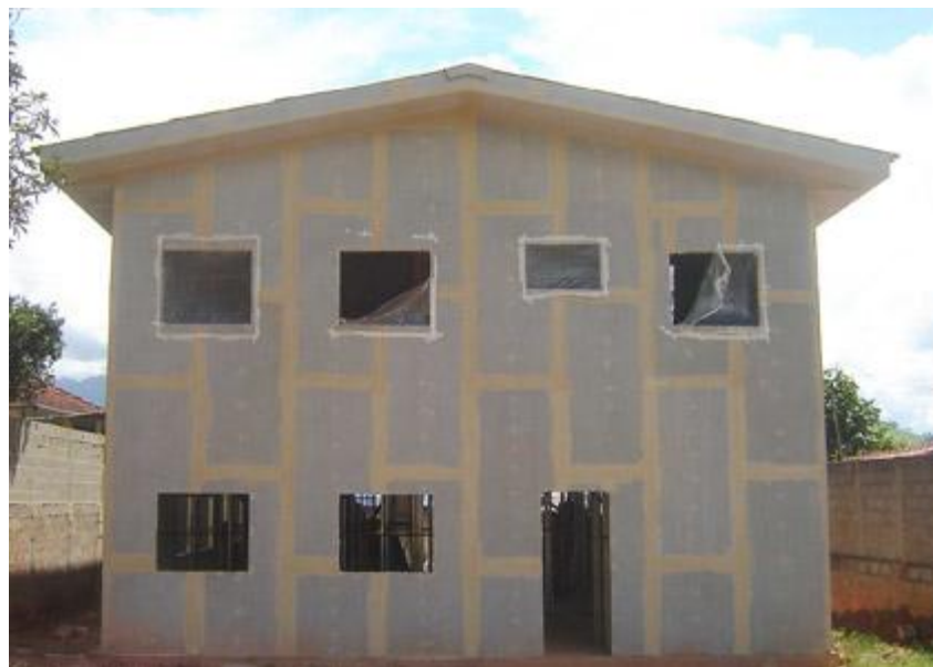
Figura 41 – Imagem das placas cimentícias externas
