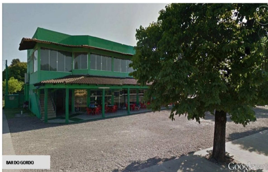
Figura 3 – Fachada do Bar do Gordo
