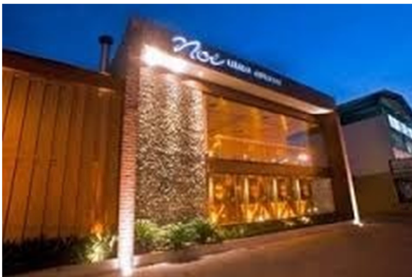
Figura 61 – Cervejaria Noi em Niterói RJ – Fachada e acesso principal
