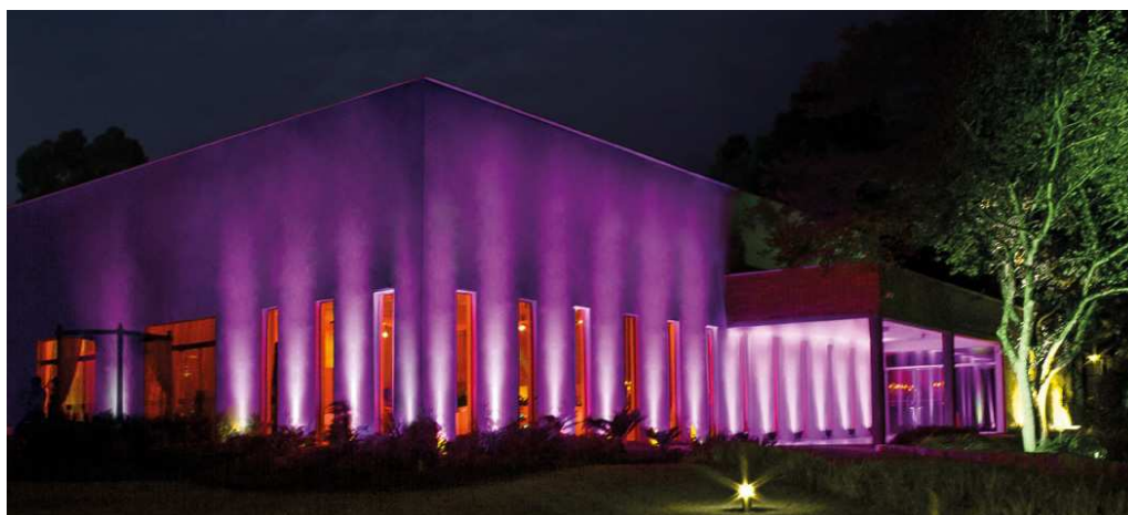
Figura 34 – Edificação e Iluminação.
