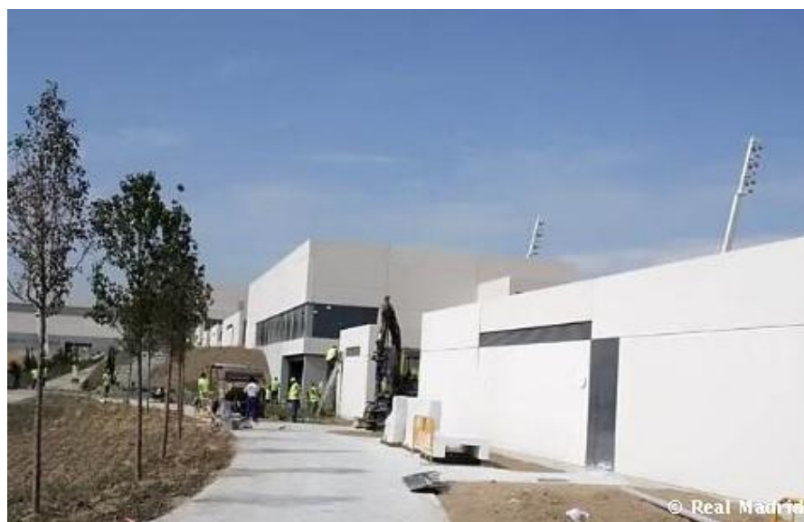
IMAGEM 50 – Vista externa dos prédios. Disponível em: < http://www.realmadrid.com/cs/Satellite/en/Club/1193041516878/Historia/Real_Madrid_City.htm >. Acessado em: 15 abril. 2009.
