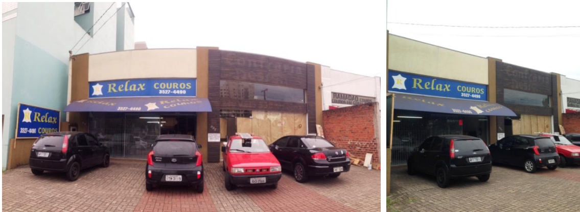
Figura 36 e 37 - Avenida Vitor Hugo Kunz Lojas existentes a demolir
