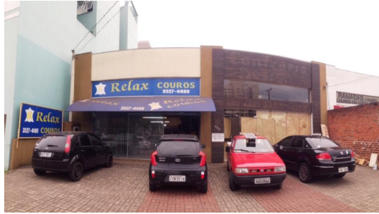
Figura 33 – Edificação que será demolida
