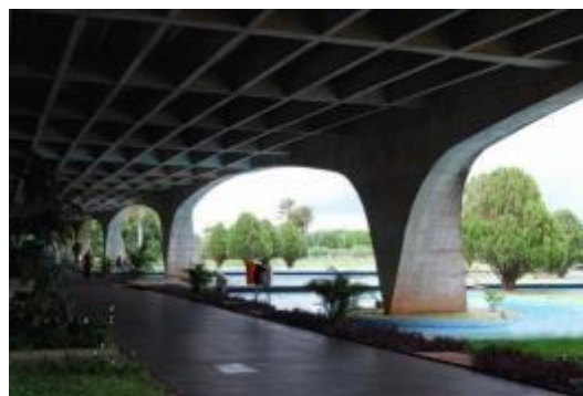
Figura 49 - Vista Interna dos Pórticos
