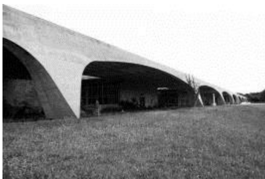
Figura 48 - Vista Externa dos Pórticos
