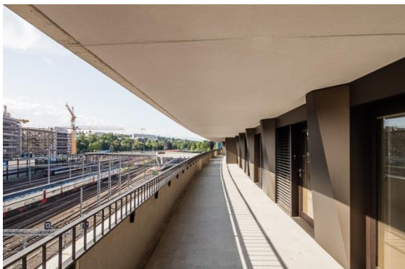
Figura 21 – Lado oeste das unidades.
