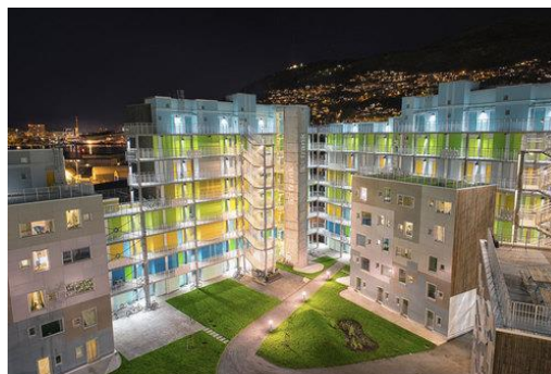
Figura 48 – Vista do pátio interno das edificações.
