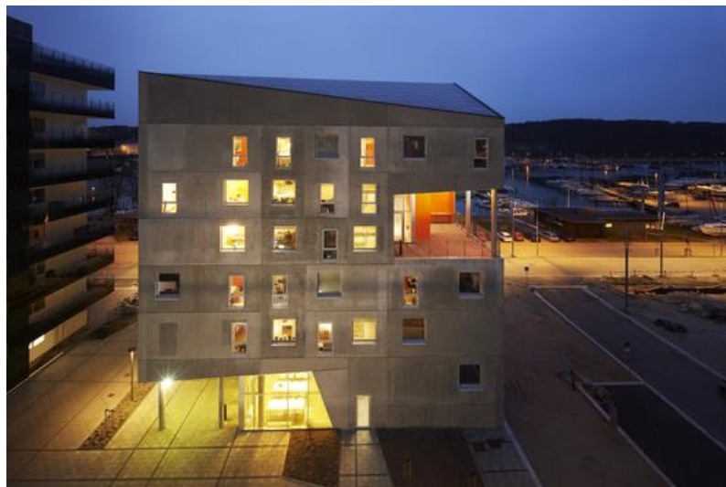
Figura 39 – Perspectiva frontal da edificação.
