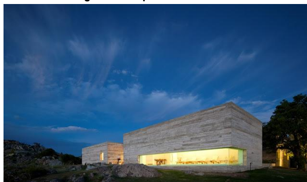
Figura 72 – Spa Fasano Las Piedras
