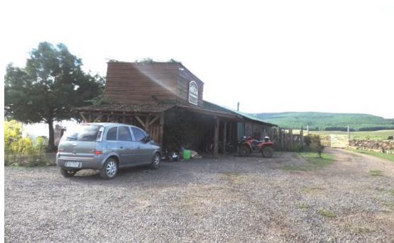
Figura 26 – Alojamento dos funcionários
