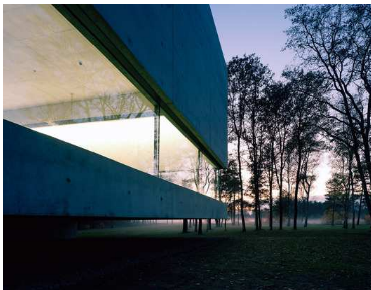
Figura 56- Vista lateral da fachada destacando o balanço.
