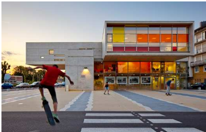
Figura 53 - Vista fachada principal.
