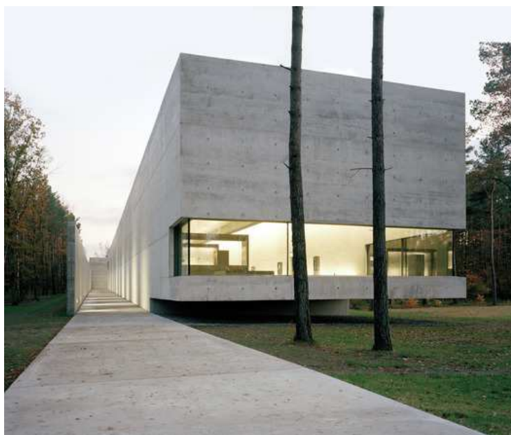
Figura 55 - Vista fachada principal.
