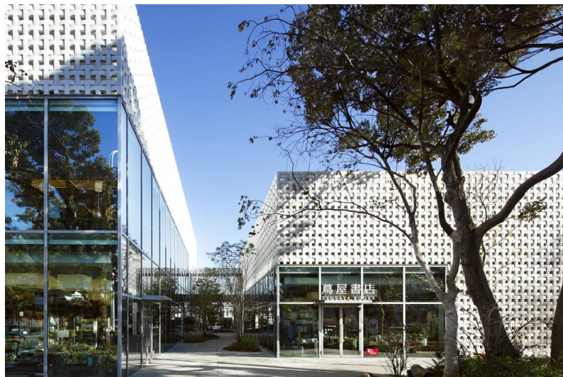
Figura 53 – Revestimento das fachadas
