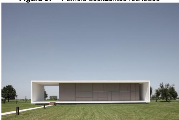
Figura 57 – Painéis deslizantes fechados
