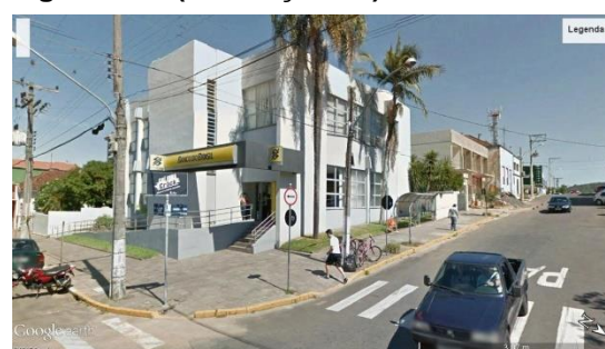
Figura 70 – (edificação 07) Banco do Brasil
