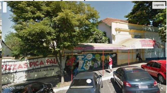
Figura 77 – (edificação 14) Pazz. Pica Pau
