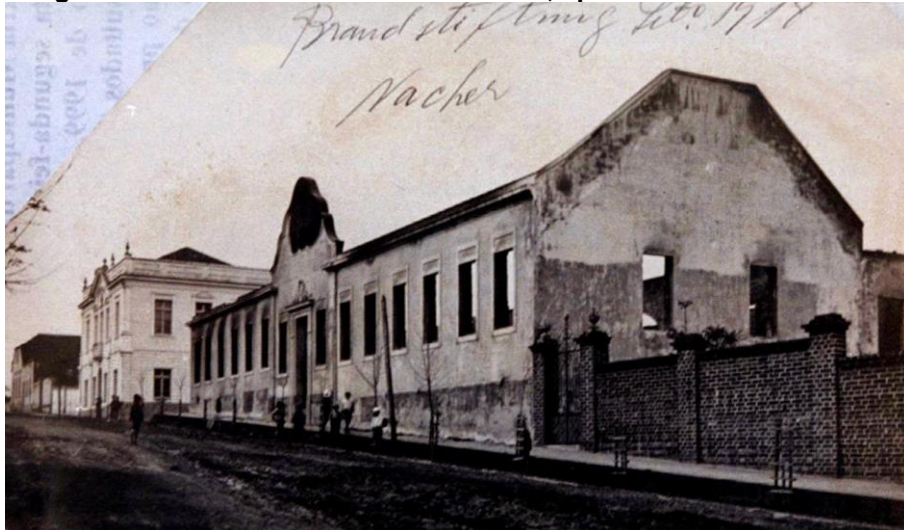
Figura 1 - Prédio da Sociedade Ginástica, após o incêndio em 1918.
