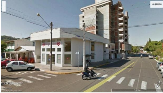
Figura 72 – (edificação 09) Assemb. De Deus
