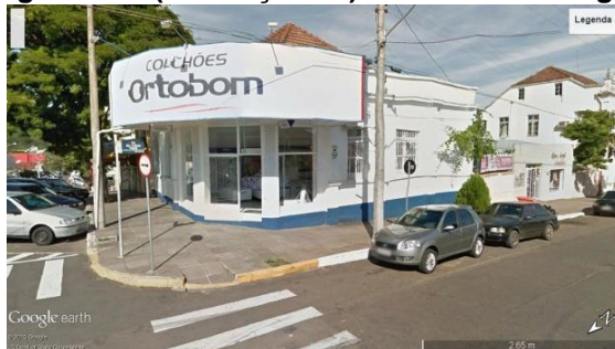
Figura 76 – (edificação 13) C. Ortobom
