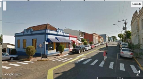
Figura 67 – (edificação 04) Ponto Dez
