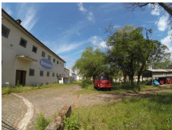
Figura 29: Edificação vizinha testada sul
