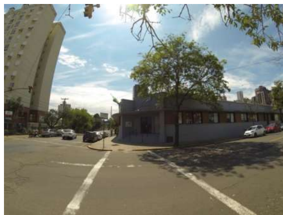
Figura 30: Edificação vizinha testada norte
