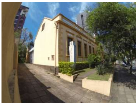
Figura 8: Fachada leste - acesso secundário
