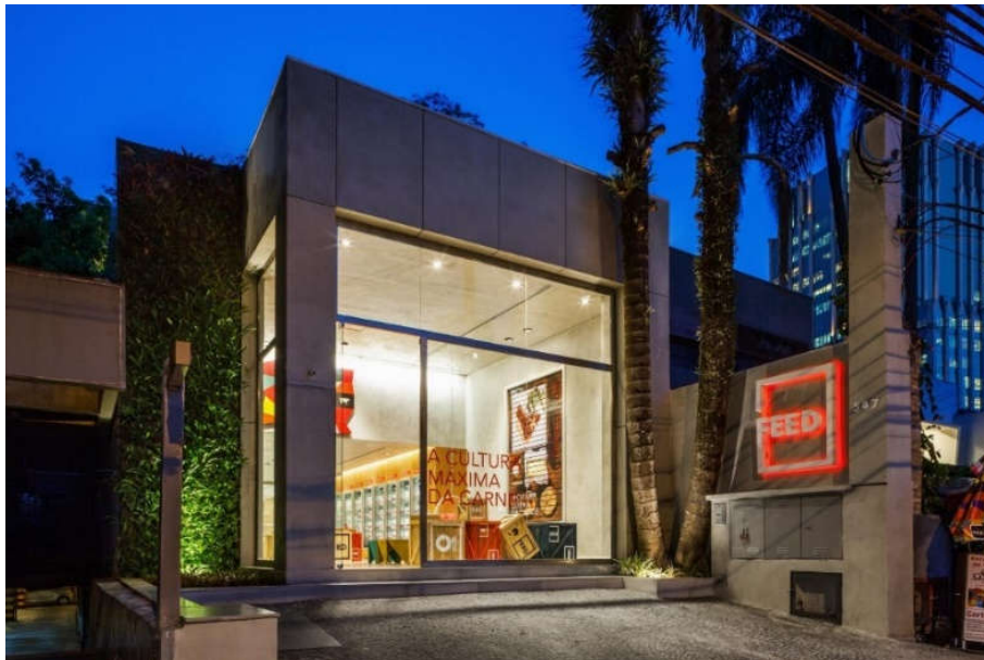
Figura 38 - Fachada principal do projeto
