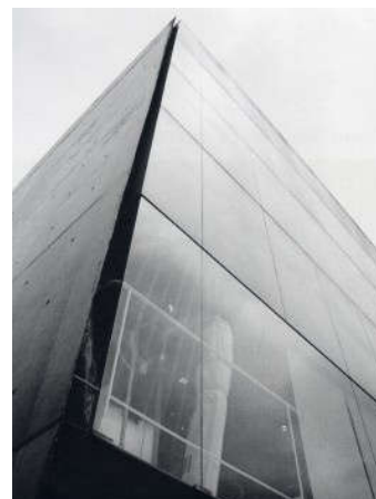
Figura 71 - Lateral do edifício
