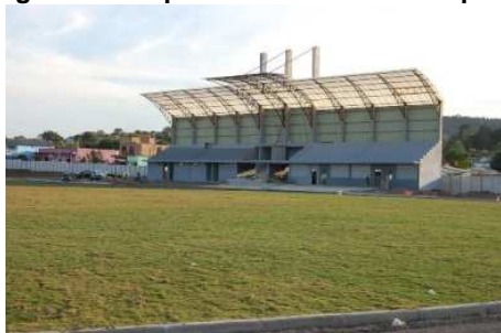
Figura 32: Arquibancada da Vila Olímpica
