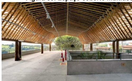
Figura 80: Espaço coberto multiuso
