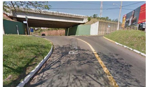
Figura 57: Rua Jacob Willers que dá acesso a RS 239
