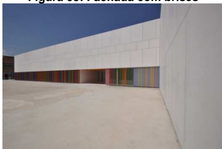
Figura 93: Fachada com brises
