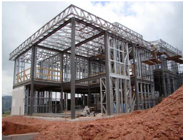
Figura 131: Exemplo painéis de parede montados
