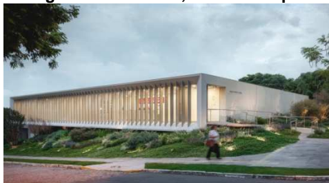
Figura 66: Fachada, acesso rampa
