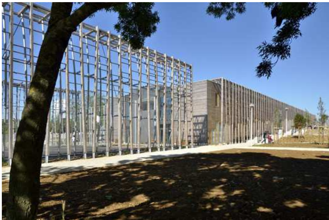
Figura 34 - Vista da estrutura do projeto
