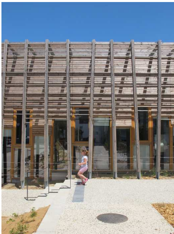
Figura 35 - Vista dos elementos construtivos do projeto
