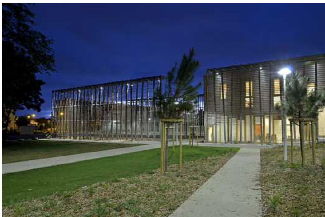
Figura 33 - Vista da Fachada do projeto
