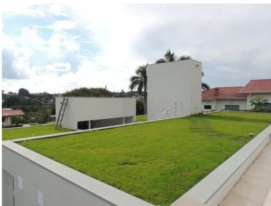
Figura 49 – Imagem de cobertura Verde
