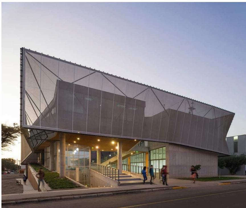
Figura 42 - Fachada da edificação
