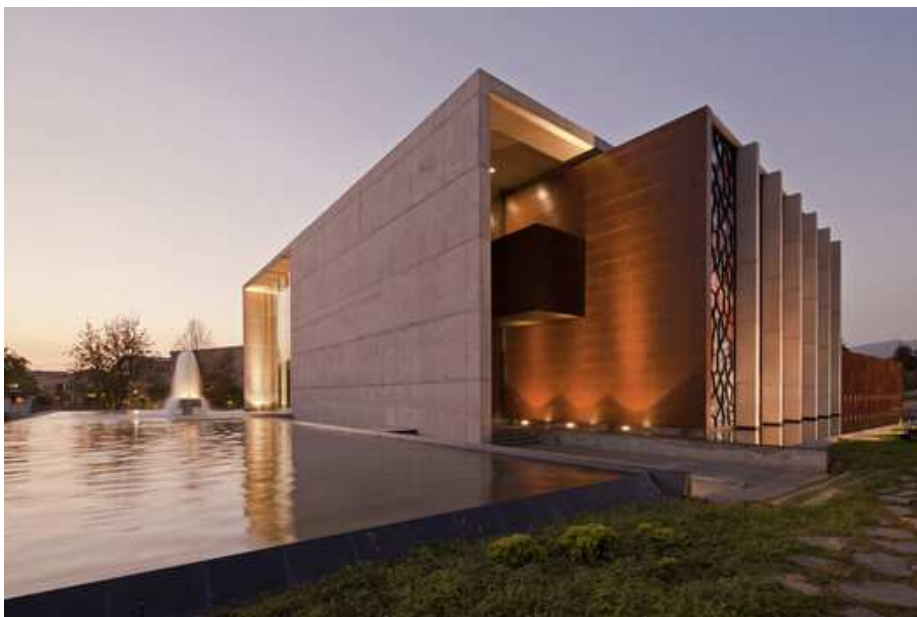
Figura 30 - Vista da fachada do projeto
