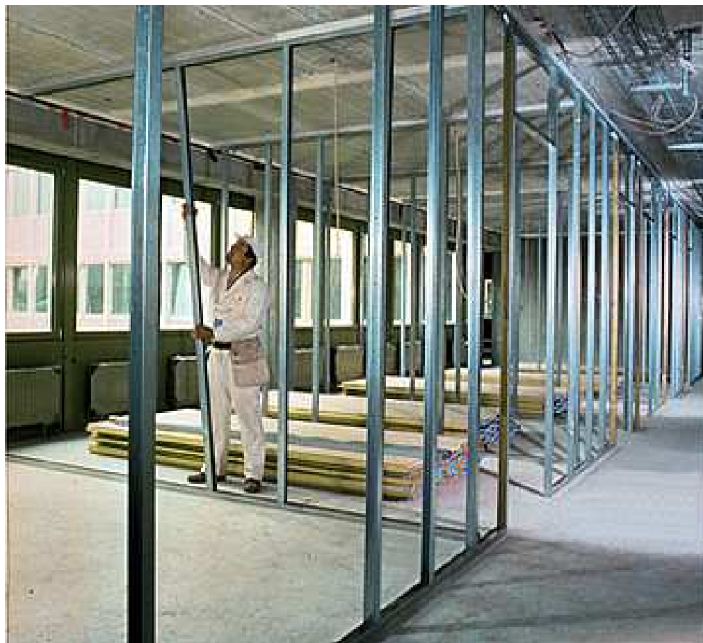
Figura 46 – Divisórias Steel Frame
