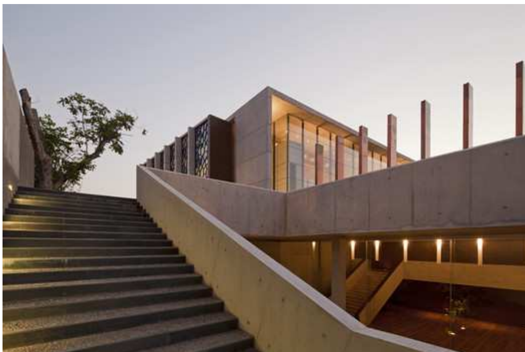
Figura 28 - Vista da Fachada do projeto
