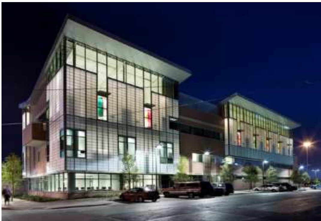
Figura 25 - Vista da fachada do projeto
