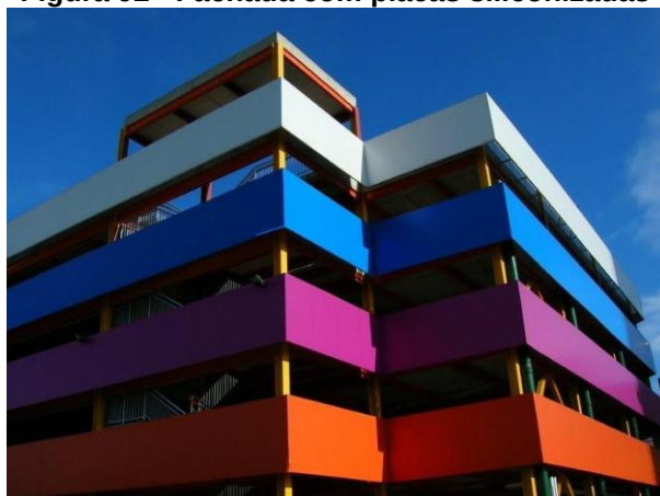
Figura 92 - Fachada com placas siliconizadas
