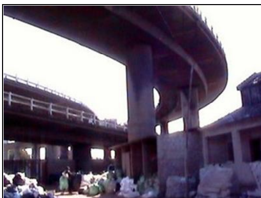
Figura 32 – Instalações Profetas Fonte: FUÃO, 2006
