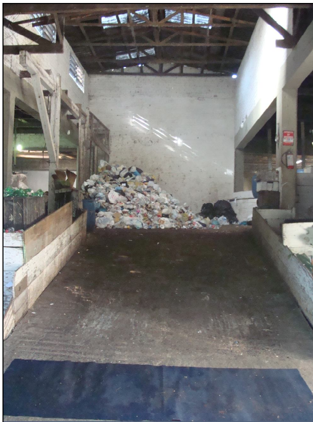
Figura 21 - Rampa de descarregamento do lixo Fonte: AUTORA, 2009
