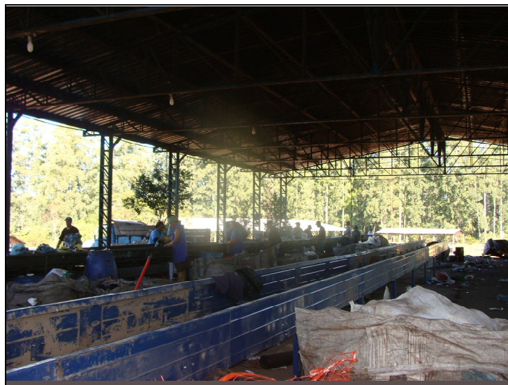
Figura 9 – Esteiras da Cooperativa COOPREL
