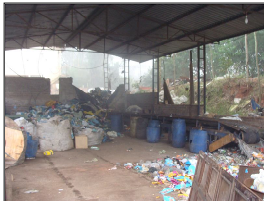
Figura 15 – Galpão de triagem Fonte: Autora, 2009.
