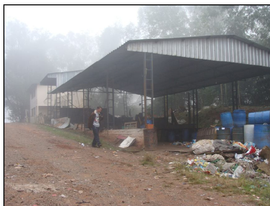
Figura 65 – Galpão de Triagem Fonte: AUTORA, 2009
