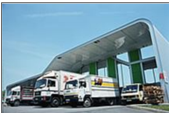
Figura 42 – Fotografia do Local Fonte: MULLER, 2009
