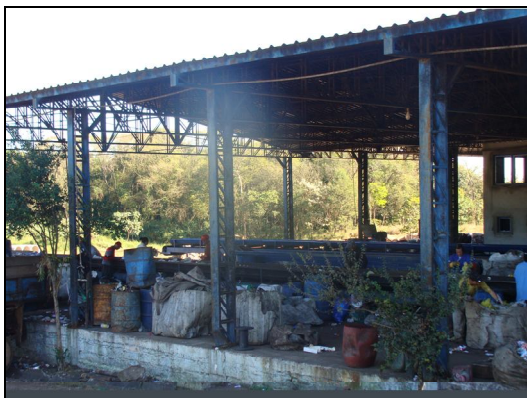
Figura 10 – Galpão de Triagem
