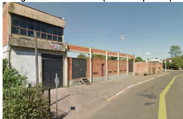
Figura 66 - Vista do lote (Rua da República)
