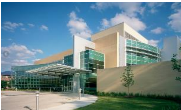
Figura 92 - Mistura de materiais na fachada
