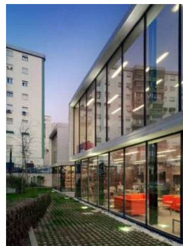
Figura 75: Fachada norte envidraçada
