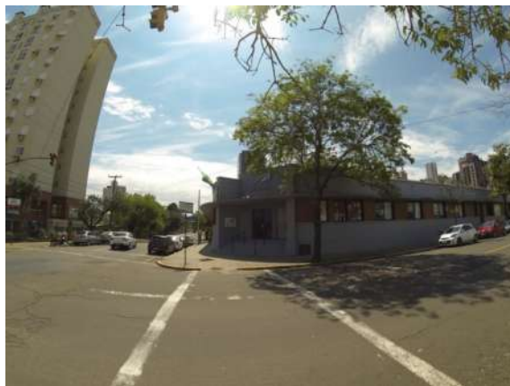
Figura 30: Edificação vizinha testada norte
