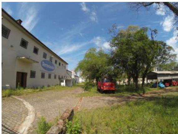
Figura 29: Edificação vizinha testada sul
