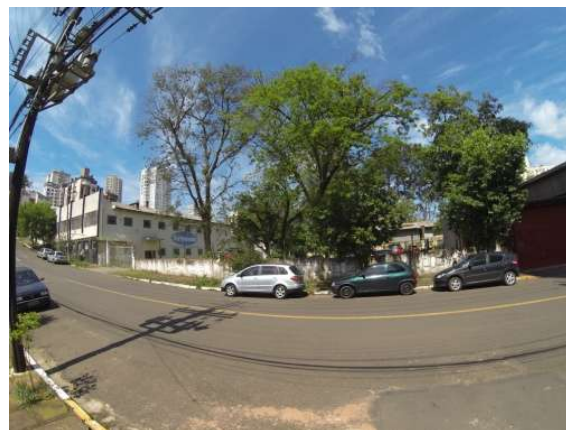
Figura 28: Acesso secundário testada leste
