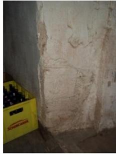
**Figura 31 - Reboco na parte externa com descolamentos**
