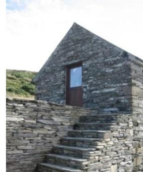
As pedras retiradas da fachada onde foi feita a abertura de vidro, foram utilizadas por artesãos locais para fazer os degraus da escada (Figura 97) que leva até o segundo pavimento pelo lado externo. O dono da casa fazia a supervisão da obra, pois desejava que detalhes originais fossem mantidos, para que a linguagem vernacular não se perdesse (ARCHDAILY, 2015).
