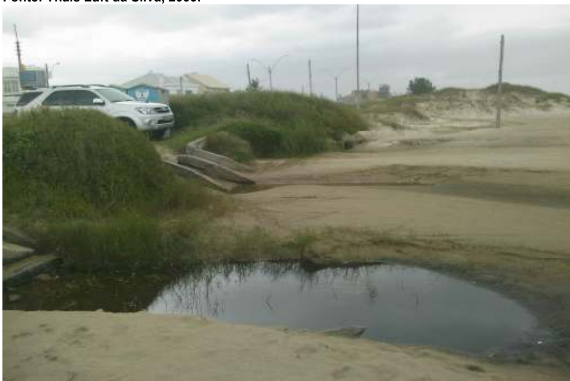
Imagem 86: Deságüe pluvial e de esgoto na faixa de praia – acúmulo de água. Fonte: Thaís Luft da Silva, 2009.
