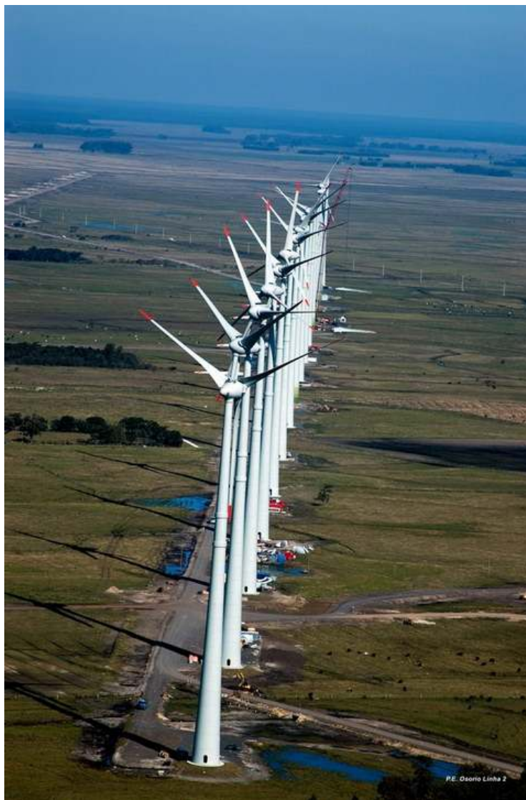
Imagem 13: Vista aérea do parque eólico de Osório. Fonte: E-BRIGADERS, 2009.
