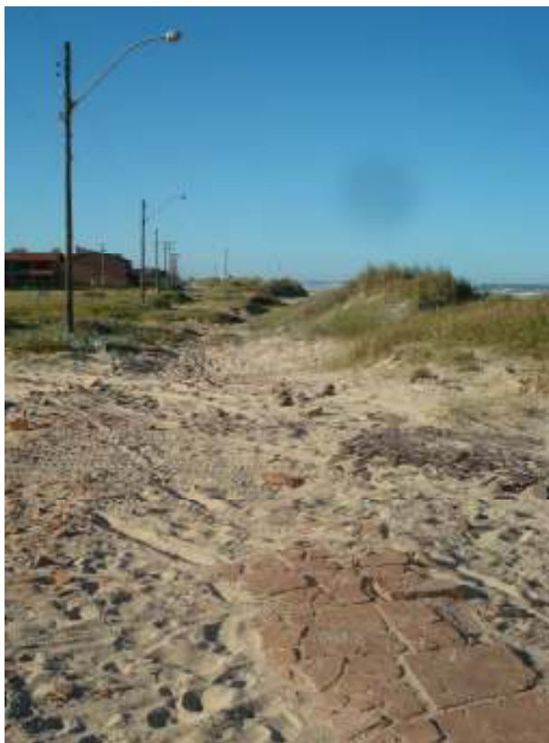
Imagem 91: Calçamento precário na beira-mar. Fonte: Thaís Luft da Silva, 2009.
