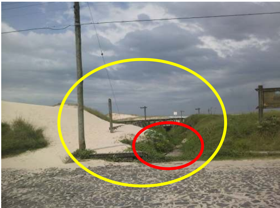
Imagem 81: “Acesso” de pedestres á faixa de praia tomado pelas dunas – Deságüe de esgoto direto na areia da praia. Fonte: Thaís Luft da Silva, 2009.
