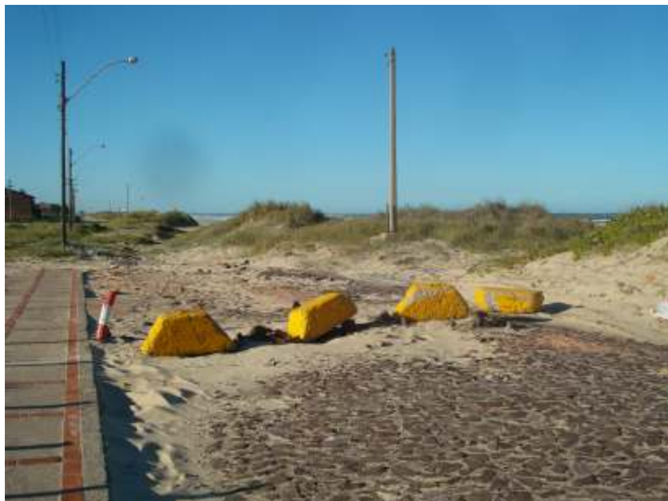
Imagens 9 e 10: Interrupção da Av. Beira-Mar no balneário de Xangri-lá/ RS – Má qualidade e falta de pavimentação. Fonte: Thaís Luft da Silva, 2009.
