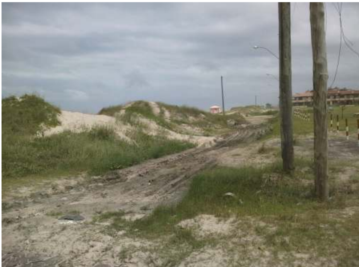
Imagem 89: Inexistência de infra-estrutura viária na Av. Beira-Mar. Fonte: Thaís Luft da Silva, 2009.
