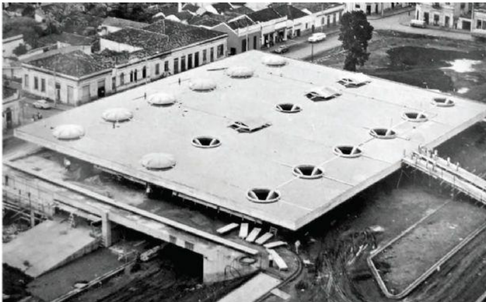
Imagem 36: A estação de Jaú em Obras. Imagem Aérea da Cobertura. 1974
