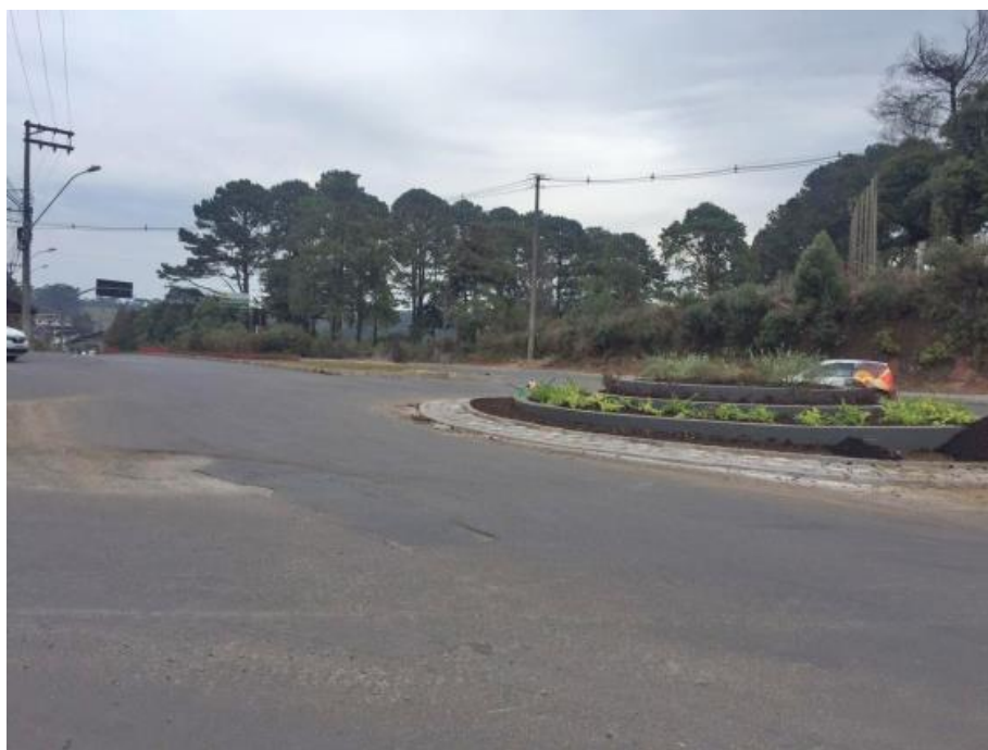
Imagem 29: Rótula em construção, RS 235. Ao fundo o Lote para a proposta de Terminal Rodoviário Turístico.
