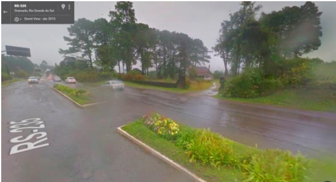
Imagem 31: Acesso principal, pela RS 235. Vista frontal do Lote. Imagem editada a partir do Google.
