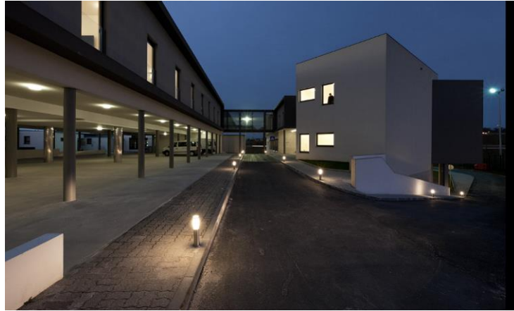
Figura 52 – Pilotis da área de lazer e estacionamento
