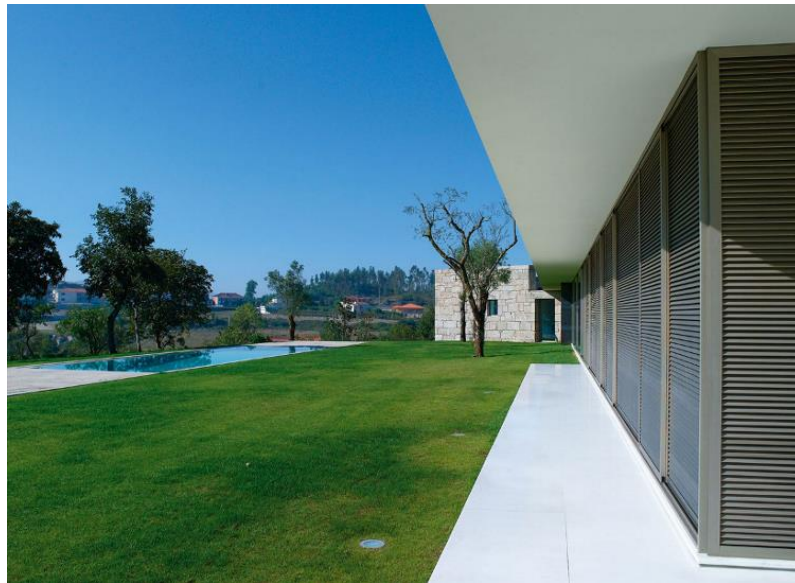
Figura 60 – Visual da edificação e pátio
