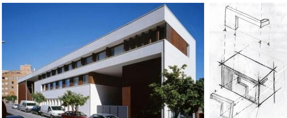
Figura 33 – Fachada frontal da residência e croqui
