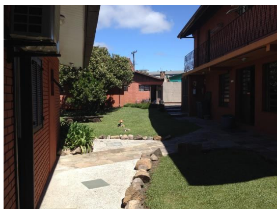
Imagem 9: Acesso do volume “A” ao “B”
