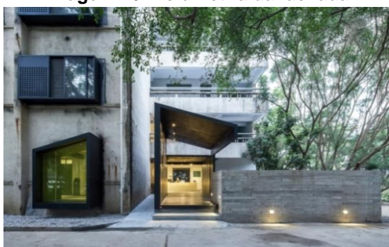
Imagem 46: Volumetria da fachada
