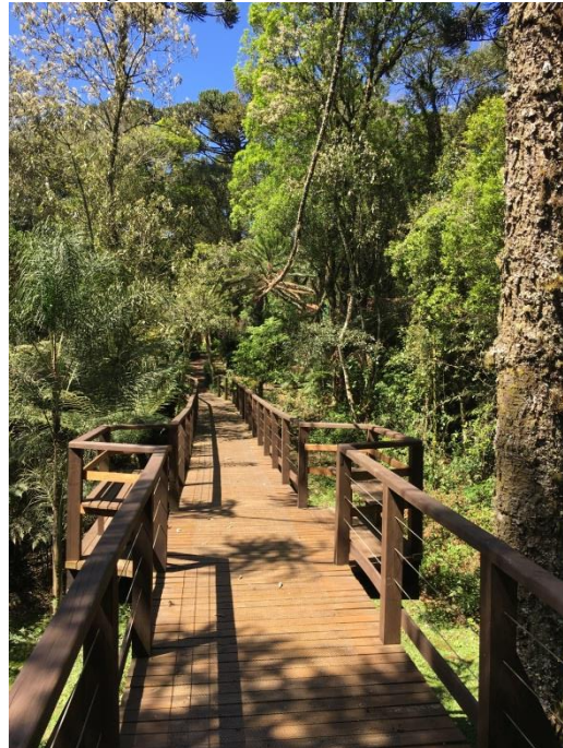
Figura 19 : passarela de pedestres
