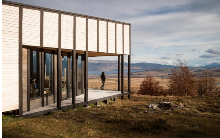
Figura 69 – vista desde a área comum (terraço / estar)
