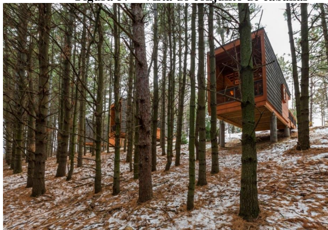
Figura 57 – Vista do conjunto de cabanas
