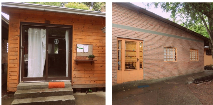
Figuras 23 e 24 – Salas de aula têm acesso independente
