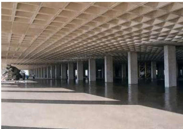
Figura 88 – Laje nervurada.
