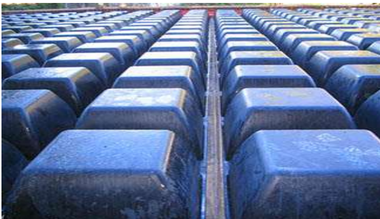
Figura 89 – Fôrmas para laje nervurada.
