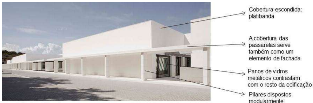
Figura 53 – Grandes passarelas de acesso
