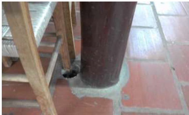
Figura 11 – Ralo de água sem proteção
