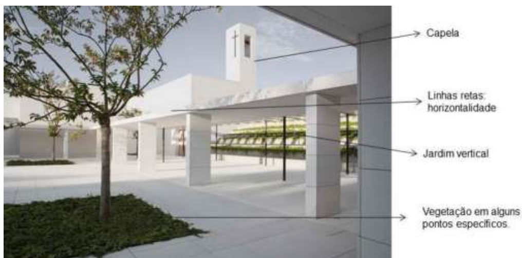
Figura 51 – Vista do pátio interno
