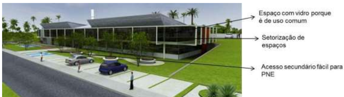
Figura 35 – Vista da fachada principal
