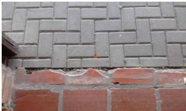
Figura 10 – Más condições do piso de acesso ao ACTG Portal da Serra
