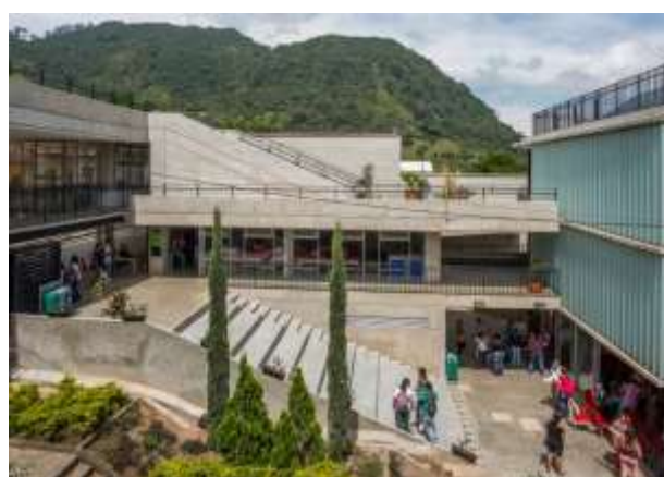
Figura 41 – Vista interna da edificação
